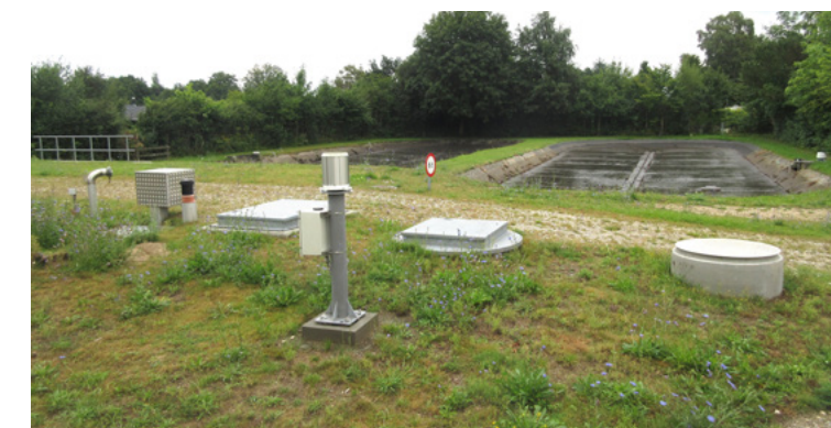
Opsamlingsbassin ved Søengen 7. Bassinet er underjordisk og gravet ned for enden de 2 ældre bassiner, der skulle forsinke regnvandets påvirkning af kloaknettet
