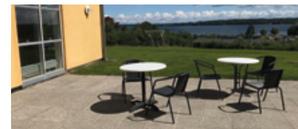
Rene fliser på terrassen
